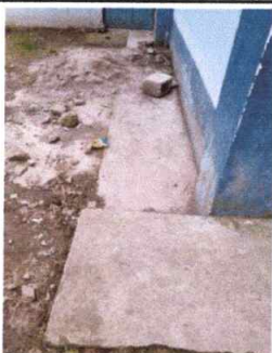
Foto 9: Reparación de planchas de concreto de patio, nivelación * sub base.
