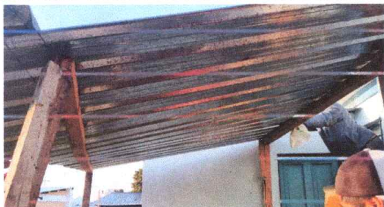
Foto 1: Sustrucción de lámina por lámina troquelada aluzinc 26.
