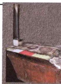
Foto 10: Sustitución de estufa rural (Completa) incluye chimenea y pancha de metal.
