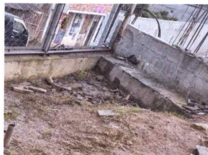
Foto 8 :Reparación de muro perimetral de block.
