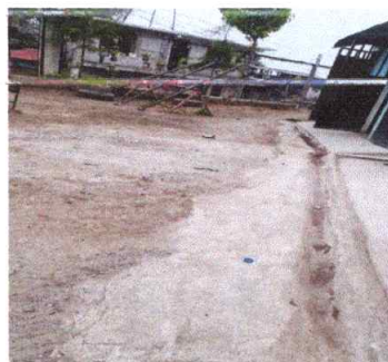
Foto 4: Reparación de cuneta de concreto.
